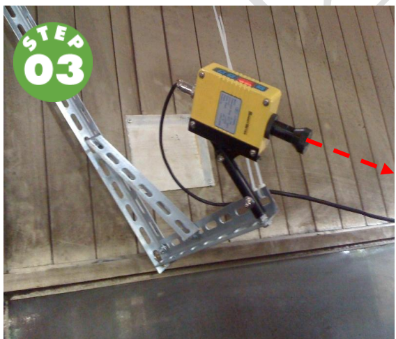
雷射定位 > 調校測試 > 安裝固定
